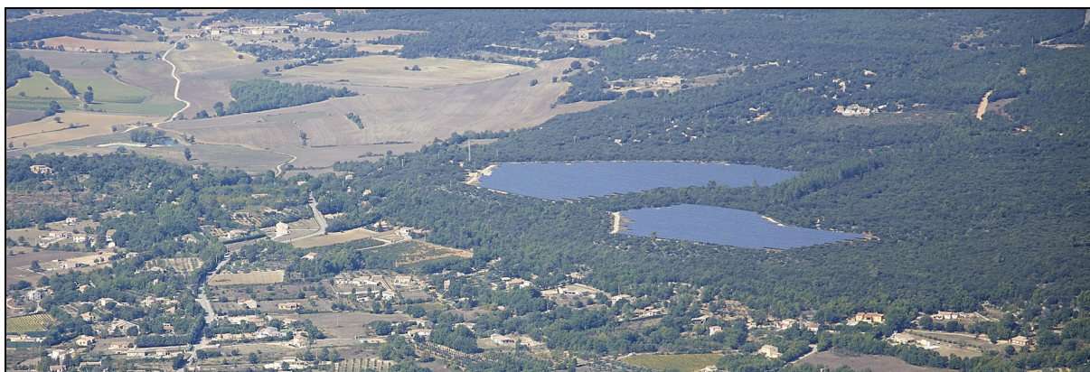
Le parc photovoltaïque de l'Auvière
